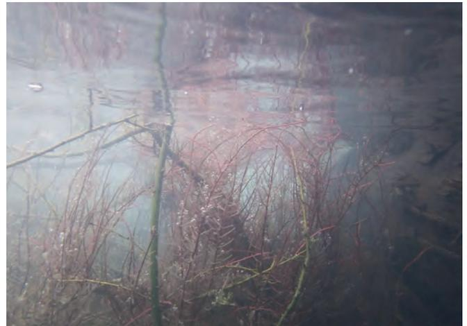
**Abbildung 8:** Rechtecke aus Längs- und Querhölzern werden auf Pfählen «aufgefädelt»; Lebende Weidenäste treiben Wurzeln unter Wasser aus.
