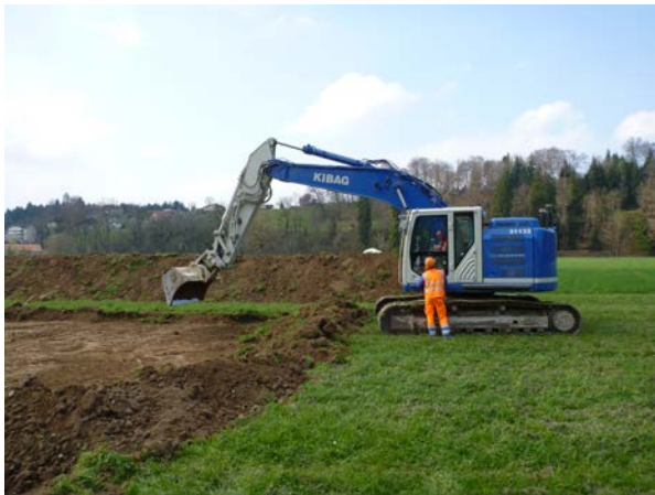
Bodenabtrag und Zwischenlager
