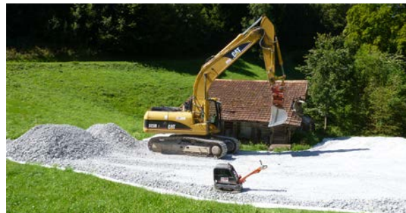
Zum Schutz des Bodens wird der Installationsplatz mit einer Kiesschicht eingekoffert
