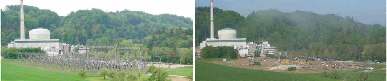
Abb. 5: Kernkraftwerk Mühleberg und Teilrückbau der 220-kV-Freiluftanlage West (2008 und 2013)
