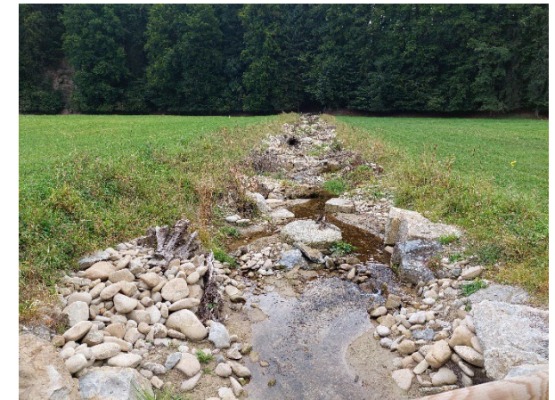
Bueebach, ausgedolter Bachlauf (Sommer 2021)
