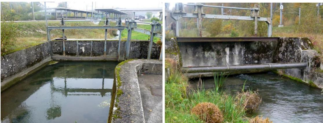
**Abb. 56:** Tafelschütz am Brunnbach oberhalb der Station Roggwil-Wynau von oben (links) und von unten (rechtes Bild)
