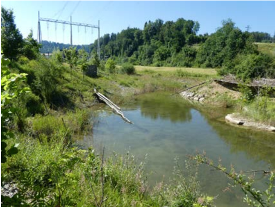
Angelegter «Altarm» als Ersatzmassnahme für Eingriffe in Ufervegetation bei Infrastrukturvorhaben im Raumbedarf der Aare
